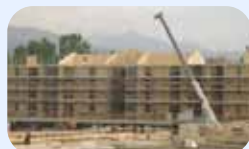
Cantiere Sassa - L'Aquila
